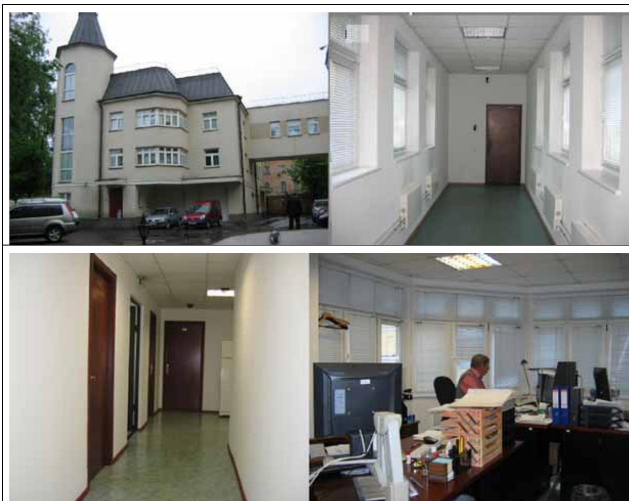
Рис. 15.3 Внешний вид здания ул. Погодинская, д.24, стр.2
